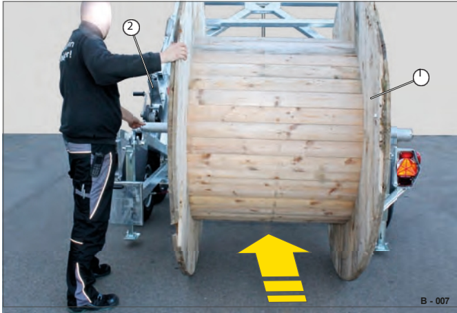
Fig. 10 Införande av kabelvinda
