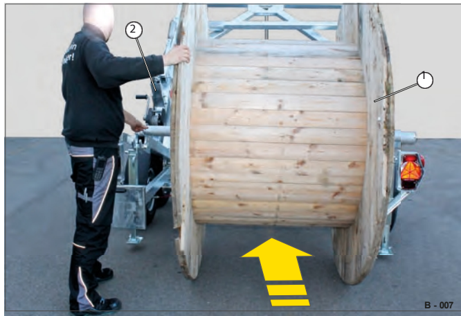
Rys. 10 Wprowadzanie bębna kablowego
