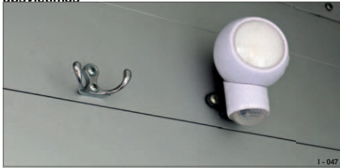
99 pav. 99 LED lemputė, maitinama iš akumuliatoriaus
