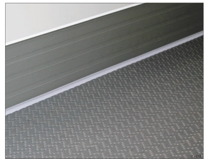
Fig. 19 Istället för trägolv, med skrapskydd av aluminium
