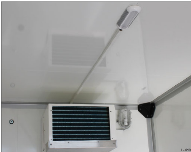
Fig. 28 12 V LED-lampa med strömbrytare
