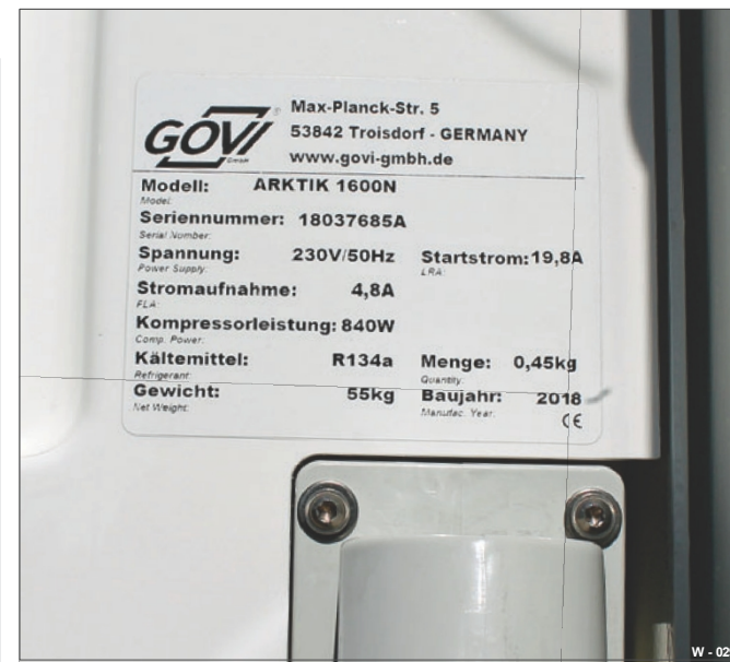
Fig. 5 Exemplo: Identificação do aparelho de refrigeração
