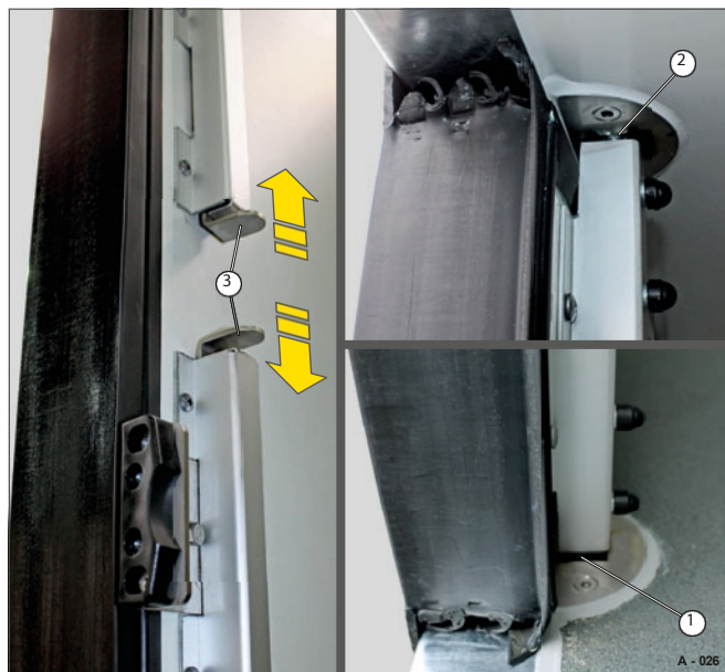
Fig. 26 Mecanismo de bloqueio da folha da porta bloqueado
