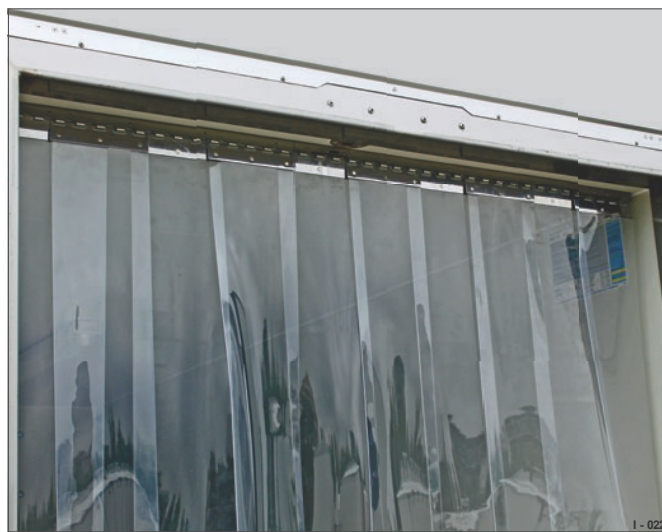
Fig. 12 Redução da perda de refrigeração
