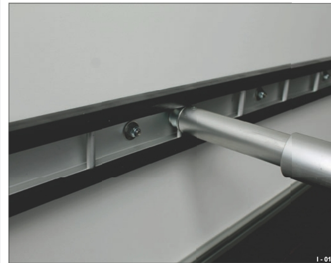
Rys. 25 Przykręcony do ściany warstwowej
