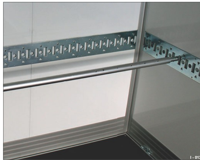
Rys. 23 Wpuszczone w ścianę warstwową
