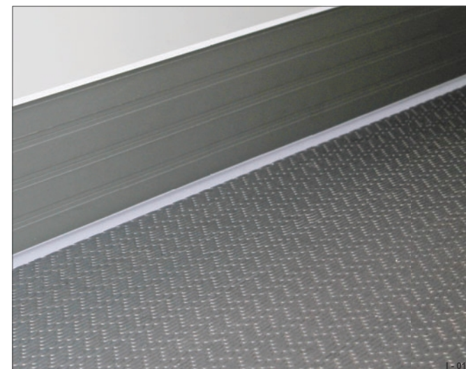
Rys. 19 zamiast drewnianej podłogi, z aluminium osłoną przeciw zarysowaniom
