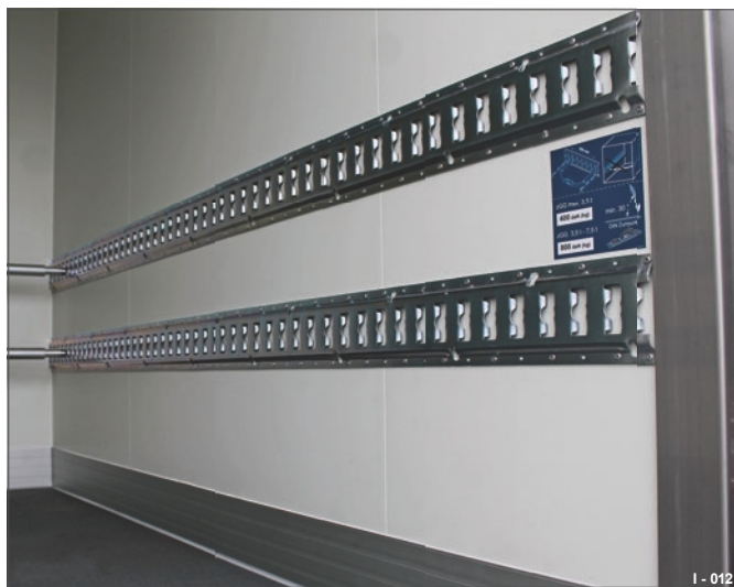
Rys. 22 Przykręcone do ściany warstwowej
