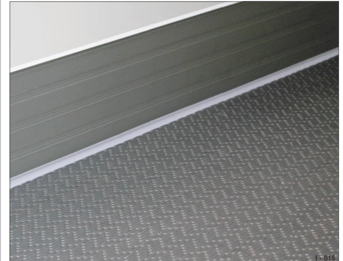
Fig. 19 i stedet for tregulv, med aluminiumsskuffbeskyttelse
