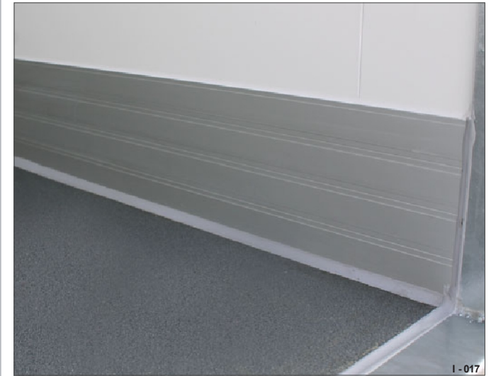
Fig. 20 65 mm bunnplate med antiskli-belegg
