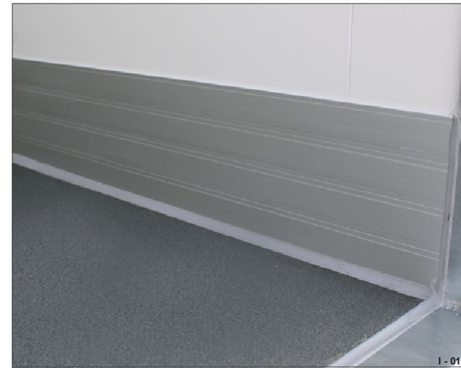
20 pav. 65 mm pagrindo plokštė su neslystančia danga
