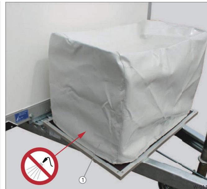
Sl. 20 Čišćenje generatora
