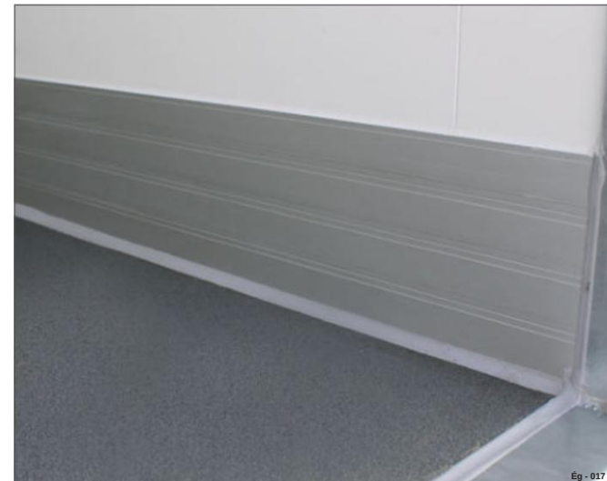
Mynd 20 65 mm botnplata með háklæðningu
