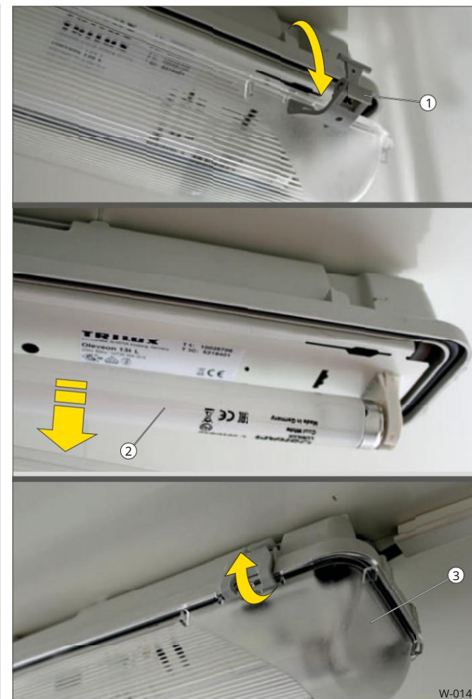
Sl. 14 Zamjena fluorescentne cijevi
