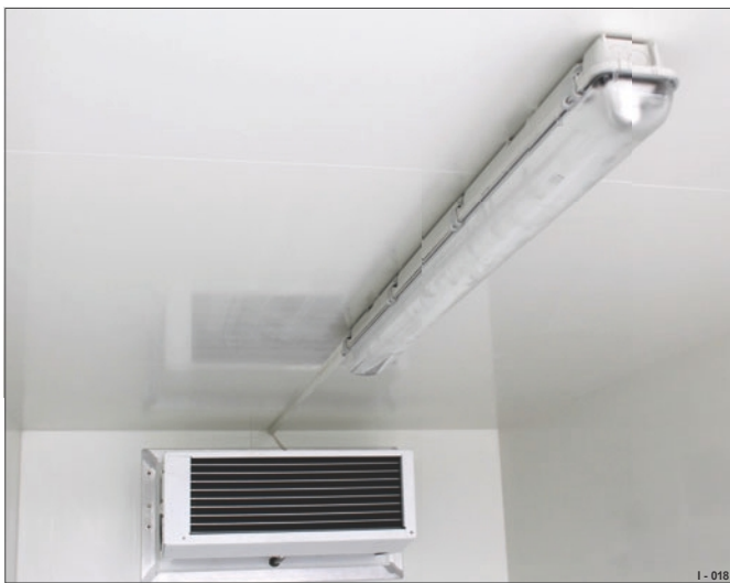
27. ábra 230 V-os lineáris lámpatest közepén felül
