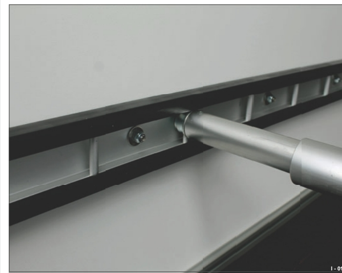
25. ábra Szendvicsfalra csavarozva
