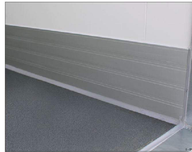
20. ábra 65 mm-es alaplemez csúszásgátló bevonattal
