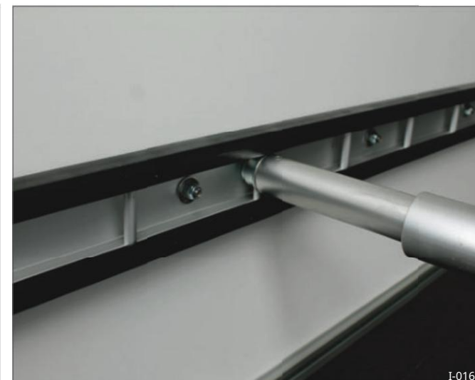
Sl. 25 pričvršćeno vijcima na sendvič zid
