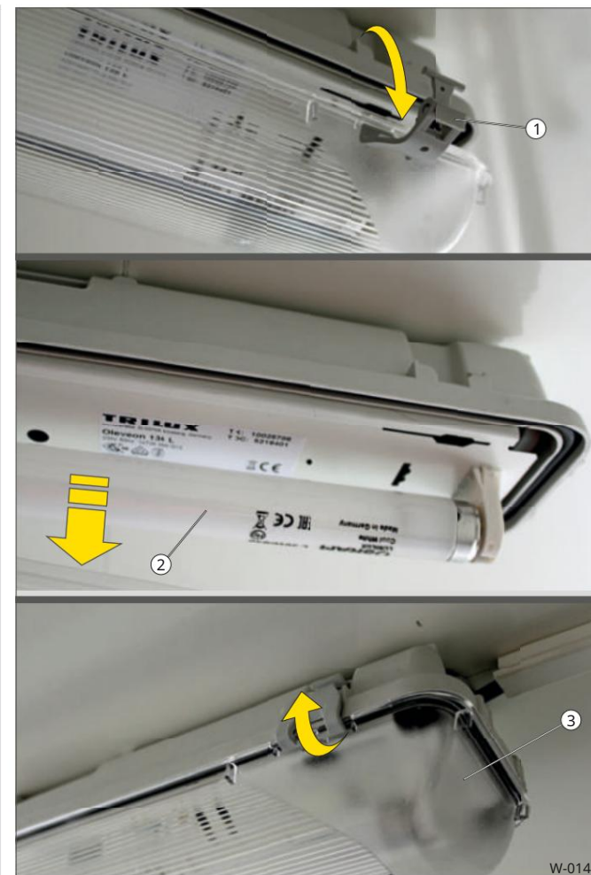
Sl. 14 Zamjena fluorescentne cijevi
