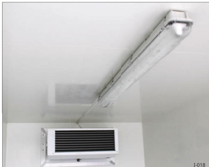
Sl. 27 Linearna svjetiljka od 230 V gornji središnji dio
