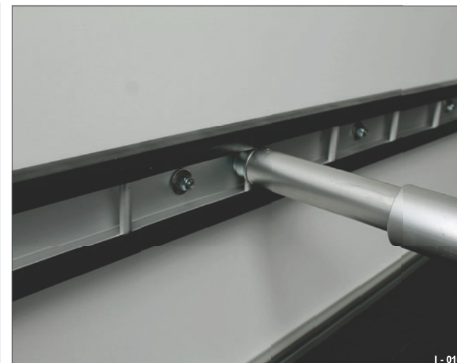
Fig. 25 Skruet fast på sandwichvæg
