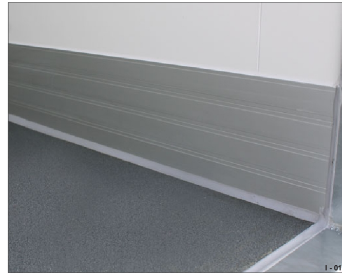
Fig. 20 65 mm bundplade med skridsikker belægning
