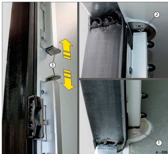
Obr. 26 Mechanismus zamykání dveřního křídla uzamčený
