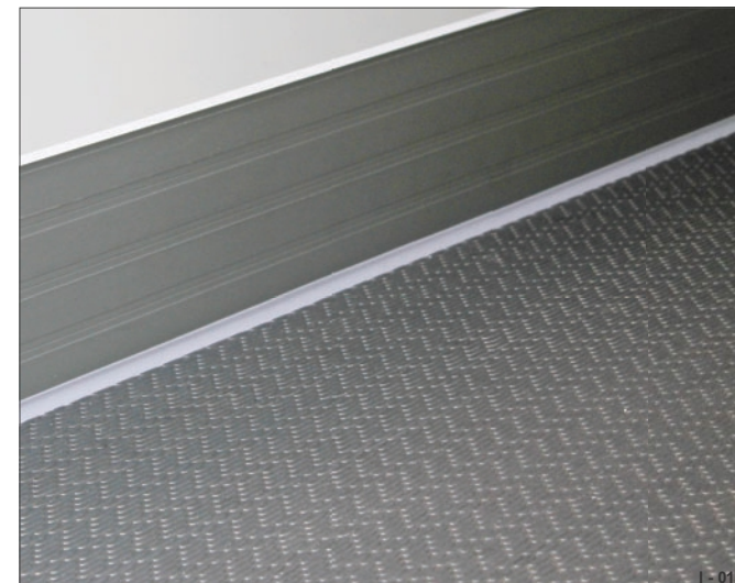
Obr. 19 místo dřevěné podlahy, s hliníkovou ochranou proti oděru
