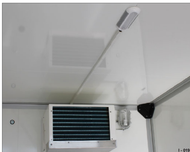
Obr. 28 12 V LED světlo s vypínačem
