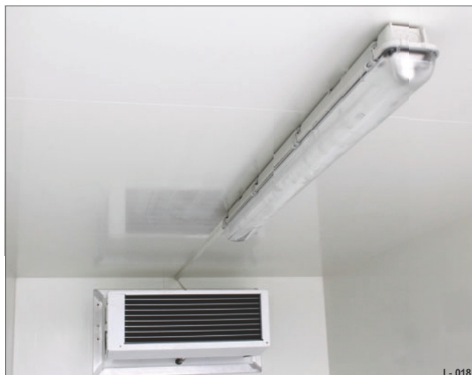
Obr. 27 Lineární svítidlo 230 V horní střed
