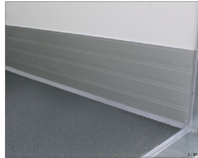
Obr. 20 Základní deska 65 mm s protiskluzovou úpravou
