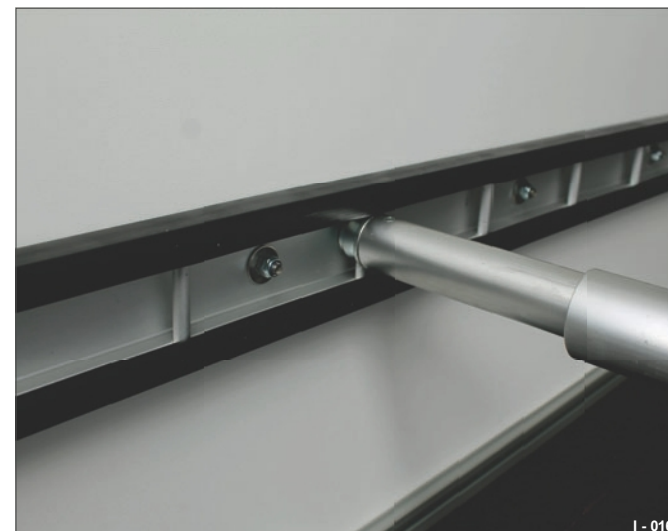
Obr. 25 Přišroubování na sendvičovou stěnu
