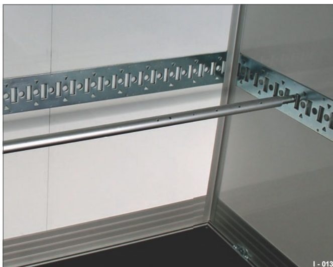
Obr. 23 Zapuštění do sendvičové stěny
