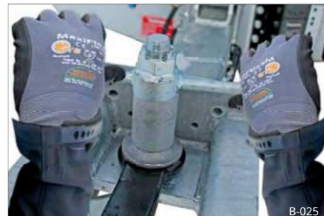
24. ábra D40 feszítőszemek rögzítése
