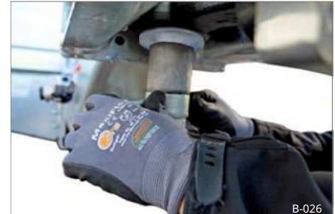
23 pav. Įtempimo kilpos D50 pritvirtintos
