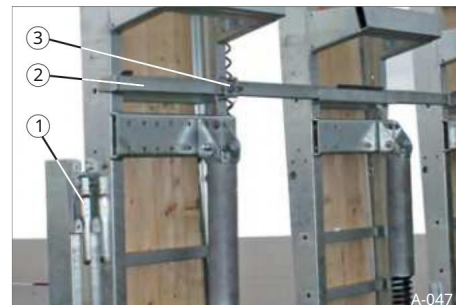
Sl. 42 Tri pristupne rampe sa sigurnosnom bravom i šipkama
