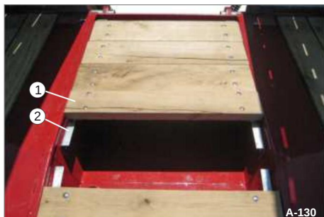
Bild 121 Tättning av grävmaskinens bomränna
