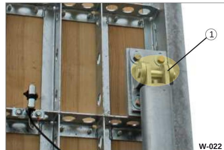
Kuva 18 Kulkuluiskien ylempi laakeripiste, jousimekanismi
